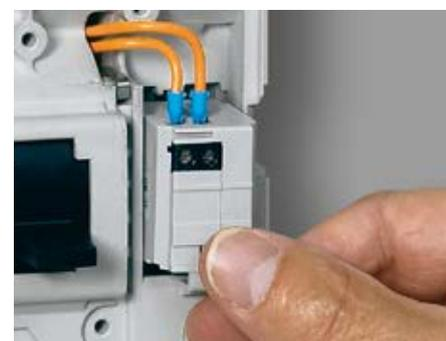
Les auxiliaires s'installent dans des logements dédiés sous la face avant.
