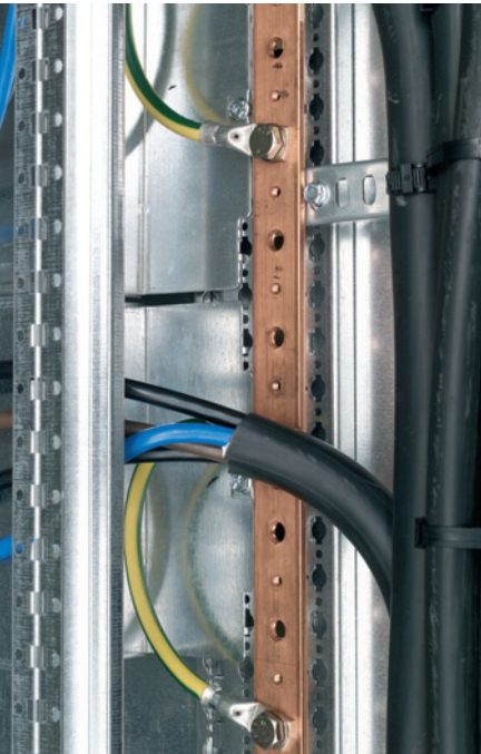
Borne principale en gaine à câbles constituée d'une barre cuivre 32 x 5 mm
