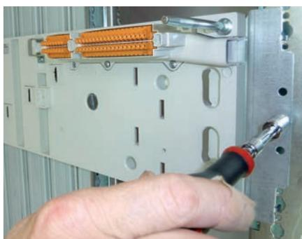
La fixation définitive sur les montants du châssis IS est réalisée à l'aide des deux vis fournies (ne pas oublier d'insérer auparavant les deux clips-écrous dans les montants).
