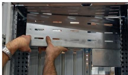
De même, pour la face avant de l'armoire, une plaque de 200 mm est prévue. Selon la hauteur du jeu de barres, elle peut être complétée par un ou deux éléments supplémentaires de 100 mm sur la partie droite du châssis colonne.
