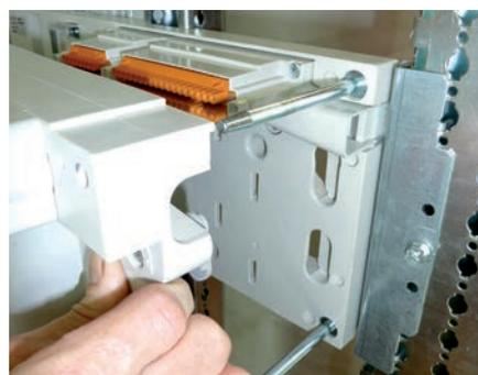
Insérer la partie mobile équipée du disjoncteur sur la partie fixe en utilisant les quatre tiges de guidages métalliques.
