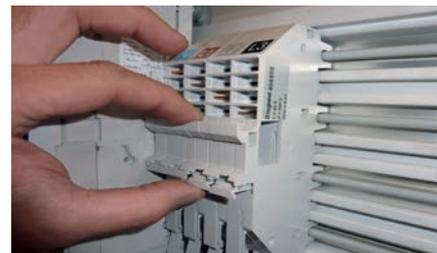
Terminer l'installation de la base support en agissant sur les leviers de verrouillage.
