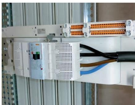
Mettre en place le cache-bornes aval, et insérer les deux accessoires de maintien (voir page 26).
