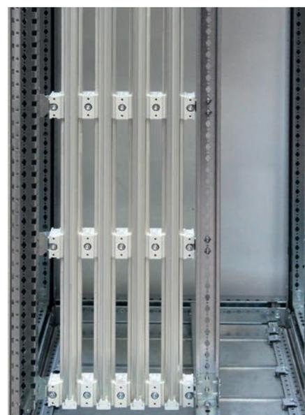
Les brides assurent la tenue mécanique des barres sur le châssis (couple de serrage : 20 N·m).
