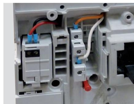
Après avoir connecté les fils aux bornes des auxiliaires, utiliser les passages prévus à cet effet pour les faire ressortir à l'arrière de l'appareil.
