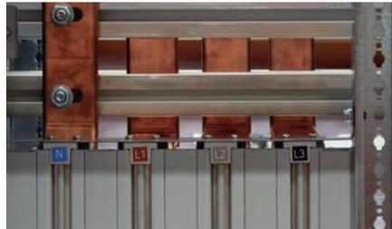
Ne pas oublier de mettre en place la plaque de repérage des barres en haut ou en bas du châssis.
