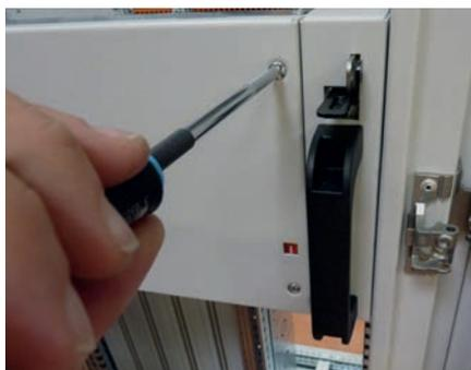
Mettre le plastron en position et serrer les quatre vis.
