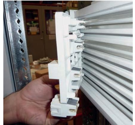
Mettre en place la partie fixe de la base support sur le répartiteur de rangée.
