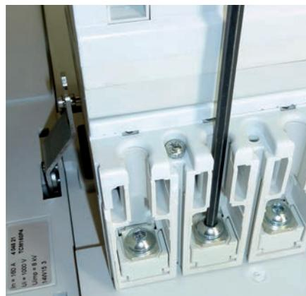
Serrer les connexions électriques amont et aval grâce aux huit (ou six) vis fournies avec la base (couple de serrage : 8N·m -> DPX<sup>3</sup> 160 ; 10N·m -> DPX<sup>3</sup> 250 ; 24N·m -> DPX<sup>3</sup> 630).
