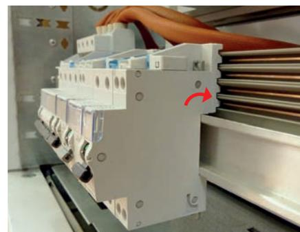
Positionner le disjoncteur sur le rail en emboîtant d'abord le bas de l'appareil, puis exercer une pression sur le haut pour mettre le disjoncteur en position. Le produit est alors automatiquement connecté au répartiteur.
