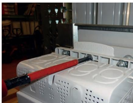
Terminer l'installation du DPX<sup>3</sup> en verrouillant les vis ¼ de tour au-dessus et en dessous de l'appareil.
