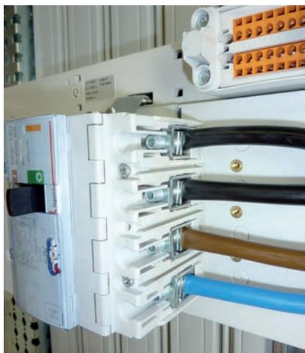
Connecter les câbles dans les bornes à cage aval du disjoncteur (couple de serrage 8 N·m).
