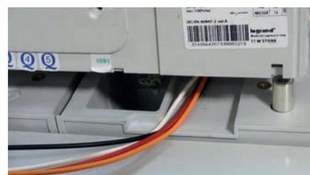
Lors de la mise en place du disjoncteur un passage est prévu sur la base pour faciliter la sortie des fils.
