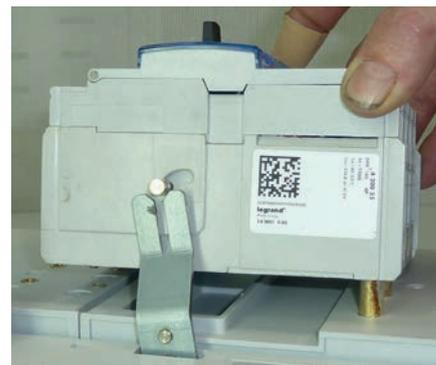
Mettre en place de l'appareil sur la partie mobile de la base, en insérant l'axe dans la fourchette du verrouillage mécanique.
