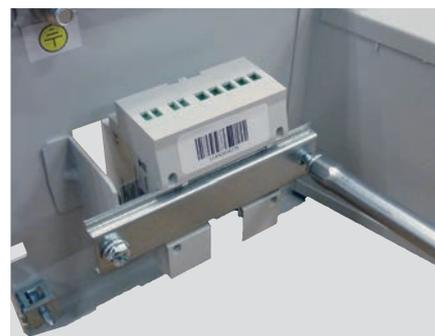
Fixer l'ensemble sur le plastron à l'aide des vis fournies.
