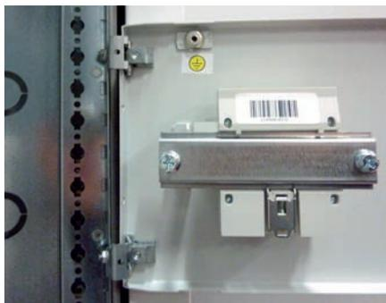
Après avoir vissé les deux charnières sur le plastron comme indiqué dans la notice, fixer l'ensemble sur le montant support plastrons en utilisant les deux écrous fournis.
