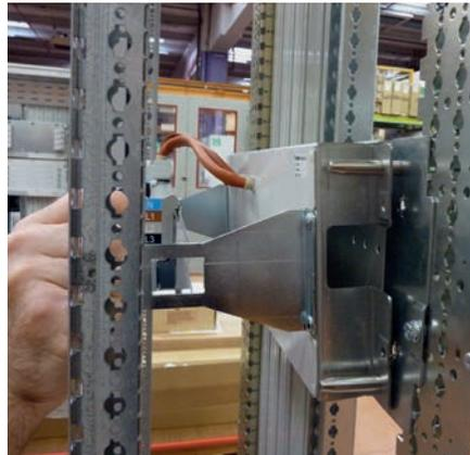
La mise en place de la partie mobile sur la partie fixe est facilitée par les 4 tiges de guidage qui garantissent un ajustement parfait des broches de connexion.
