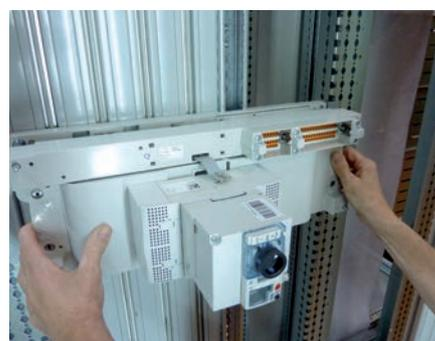
La partie mobile s'insère sur la partie fixe en utilisant les quatre tiges de guidage métalliques.
