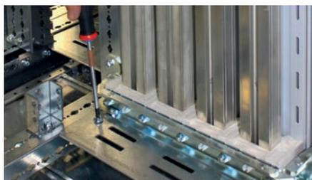
Les plaques de fermeture basse sont vissées sur les équerres avant la mise en place des cloisons latérales.
