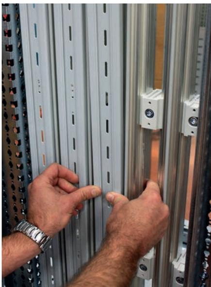
Les bandeaux isolants sont d'abord insérés dans les guides du support talon. Ils sont ensuite clipsés sur les barres à partir du bas, en exerçant une pression sur les côtés.
