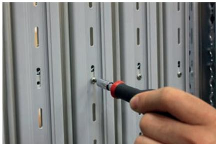
La fixation définitive des bandeaux est assurée par cinq rangées de cinq vis fixées sur les brides (couple de serrage : 1 N·m).
