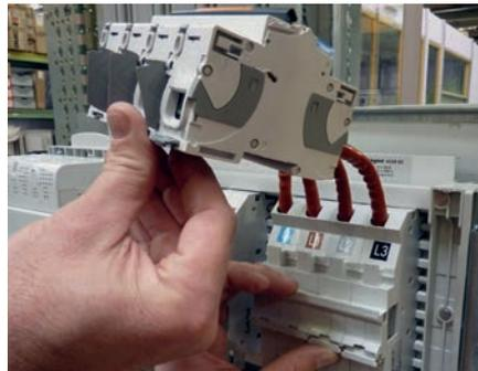
Tout en maintenant le disjoncteur d'une main, installer la base sur le répartiteur de rangée HX<sup>3</sup> IS 400 A et actionner les leviers de verrouillage.
