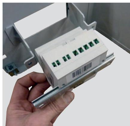
Ouvrir la fenêtre prédécoupée dans le plastron puis installer l'appareil modulaire sur le rail DIN.
