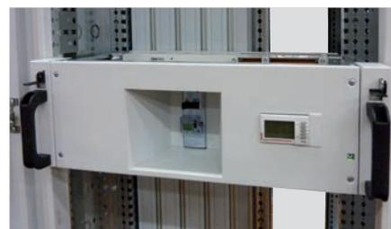
Une fois l'assemblage terminé, le câblage de l'appareil de mesure au connecteur du tiroir peut se faire de la même façon que pour les auxiliaires du disjoncteur en utilisant les bornes libres du connecteur.
