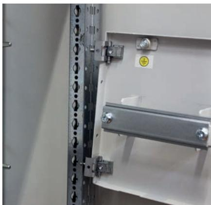
Après avoir vissé les deux charnières sur le plastron comme indiqué dans la notice, l'ensemble est fixé sur le montant support plastron en utilisant les deux écrous fournis.
