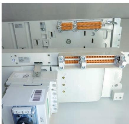
Mettre en place la partie mâle du module de raccordement sur la partie fixe de la base VX<sup>3</sup> IS et la partie femelle sur la partie mobile en utilisant les vis fournies.
