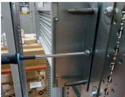
Terminer l'installation en solidarifiant la partie mobile sur la partie fixe avec les deux vis fournies.
