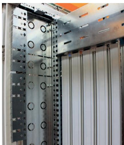
Il ne reste plus qu'à fixer les deux plaques de séparation latérales avant sur les montants du châssis colonne.
