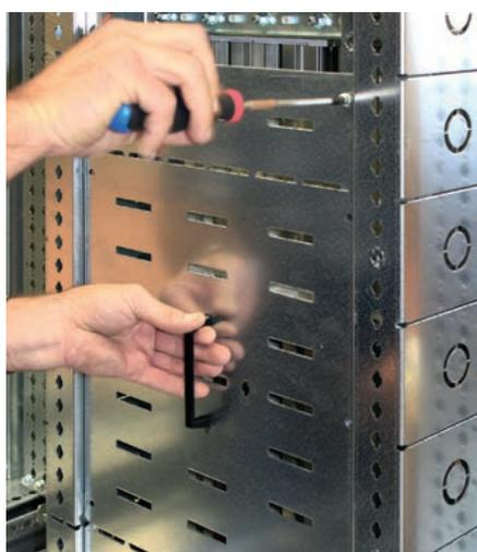
Les plaques de fermeture arrière se manipulent à l'aide d'une poignée amovible fournie dans le kit. Elles sont vissées sur les cloisons latérales.
