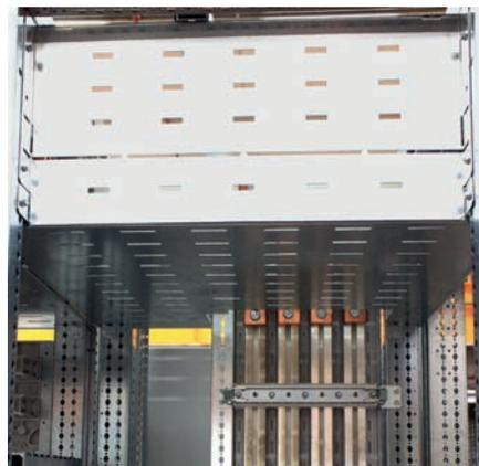
La séparation du jeu de barres horizontal doit être complétée par une plaque arrière. Cette séparation est livrée pour un cloisonnement de hauteur 400 mm mais peut être adaptée à 200 ou 300 mm.
