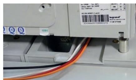
Lors de la mise en place du disjoncteur un passage est prévu sur la base pour faciliter la sortie des fils.
