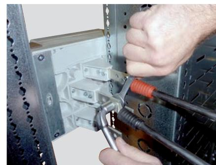
Le raccordement aval des bases IS 333 se fait par l'intermédiaire de queues de barre percées de deux trous pour vis M8 permettant le raccordement par cosses ou par barres (mettre aux couples préconisés dans la notice).
