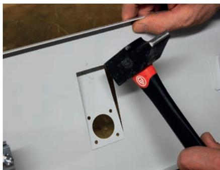
Le plastron est commun aux disjoncteurs équipés d'une commande rotative ou d'une commande motorisée. Pour cette dernière il faut casser la prédécoupe prévue à cet effet.
