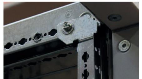
Les montants supports plastrons sont fixés dans le premier trou taraudé à 50 mm de la face avant (situé sous le symbole de terre).
