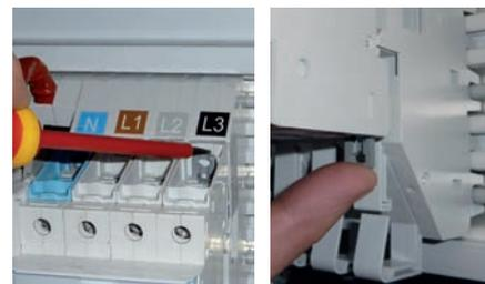
Le disjoncteur est correctement installé une fois le verrouillage sur des griffes effectué.
