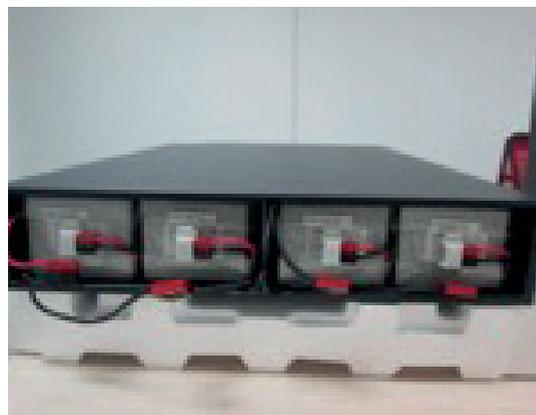
**FR** – Introduire les packs batteries dans l'armoire.
