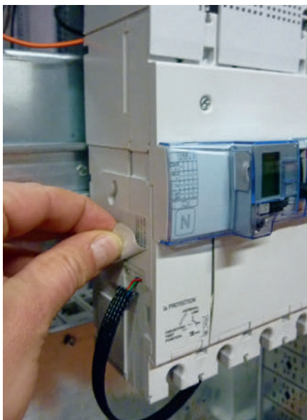
Connexion sur le côté gauche du DPX 3 , sous l'étiquette.
